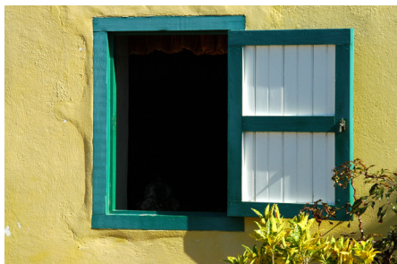
Figuur 14: Een voorbeeld van een luik van een Cunucuhuis. Foto collectie Stichting Monumentenfonds Aruba.
